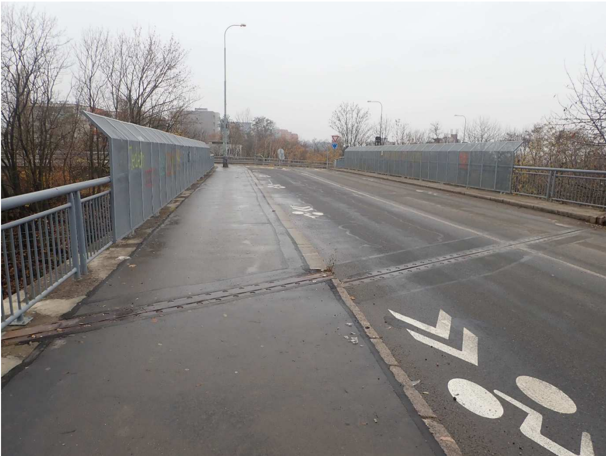
Obr. 2 – uspořádání na mostě
